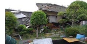
▲25・26日は、大学生ボランティアとともに、合計8軒の被災した家屋の片付けを行いました。
